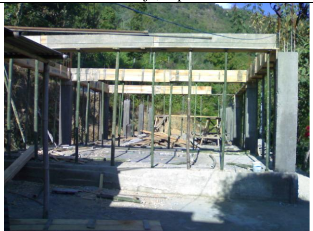
Pilarene er murt ferdig; 1. desember 2007
