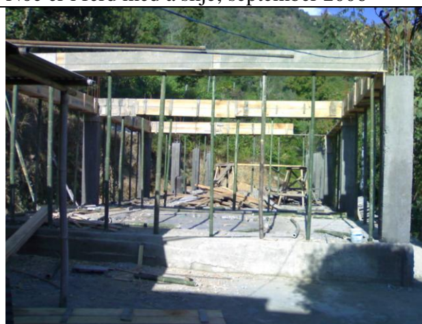
Pilarene er murt ferdig; 1. desember 2007
